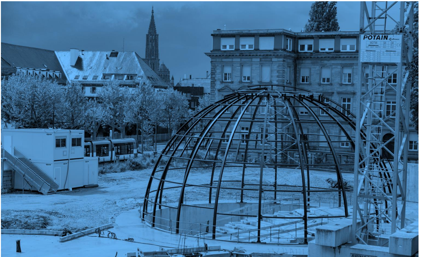
Le dôme du Planétarium en pleine construction © Catherine Schröder / Unistra
