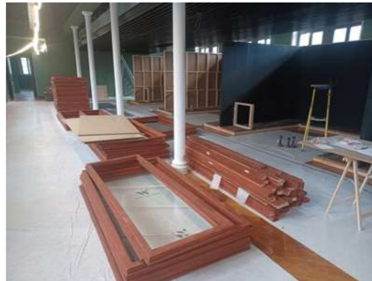
↳ Chantier de rénovation du Musée Zoologique
